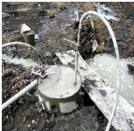
Hình 8: Một cột chống tạm bằng ống thép nhồi bê tông hoàn chỉnh [6]
