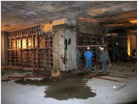
Hình 12: Thi công cột và vách cứng tầng hầm [6]
