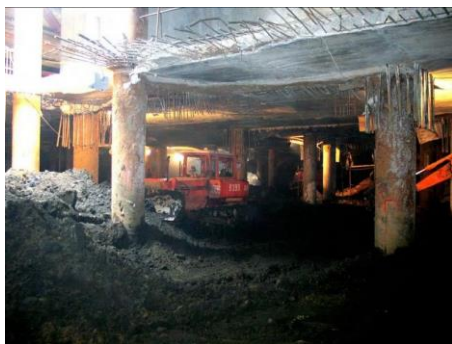
Hình 10: Thi công đào đất tầng hầm thứ nhất [6]
