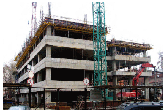
Hình 14: Một số tầng của phần thân được thi công trong lúc thi công các tầng hầm [6]
