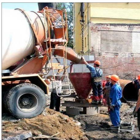
Hình 7: Đổ bê tông cọc khoan nhồi và cột thép chống tạm [6]
