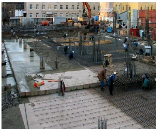
Hình 9: Thi công sàn tầng trệt [6]
